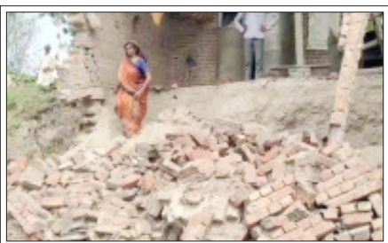
सम्भल- बाढ़ की चपेट में आकर मलबे का ढेर बना महिला का मकान।
