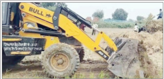
सम्भल- हल्लू सराय में 28 बीघा सरकारी भूमि खाली कराने को फसल रौंदता बुलडोजर जस्टिस।
