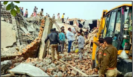
जाहिर उम्र 22 वर्ष मृत बताया जा रहा है। हादसे के वक्त मकान में अवैध निर्माण चल रहा था। ग्रामीणों ने बताया कि कुछ मजदूर वीथी मॉल पर निर्माण कार्य में लगी थी जबकि
