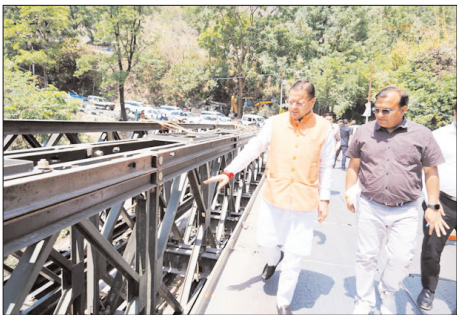
मुख्यमंत्री पुष्कर सिंह धामी (बाएं) पुल के निर्माण कार्य का स्थलीय निरीक्षण कर रहे हैं।
