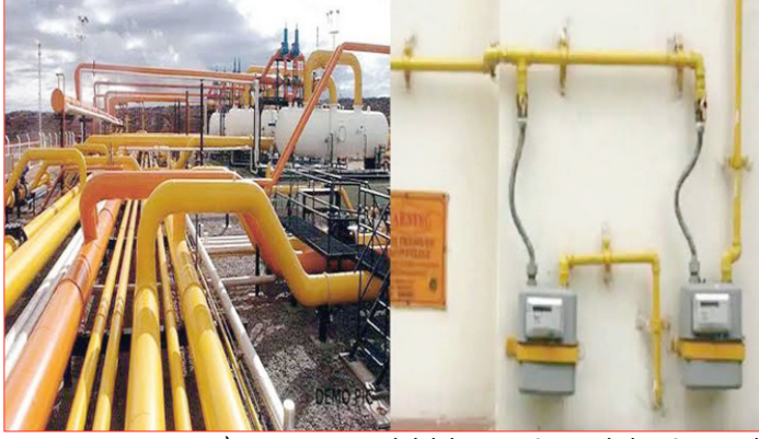
रिफिलिंग प्लांट लगाया जा रहा है। अगर उक्त प्लांट से नगर पालिका
